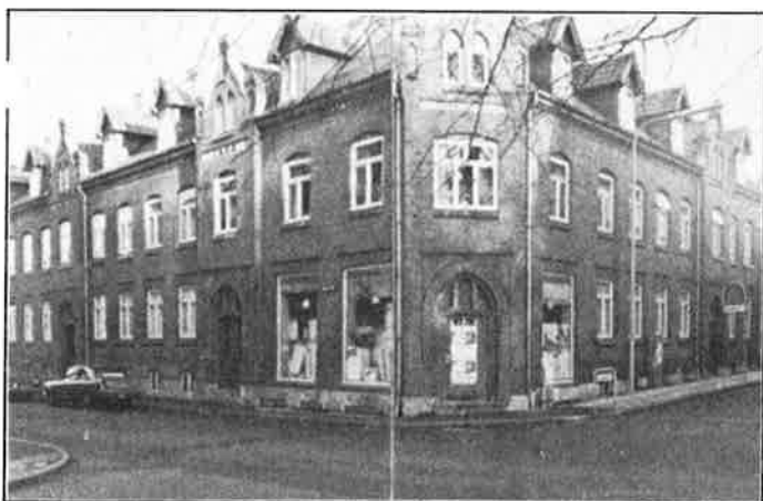
Hjørnet af Stenstuegade og Herrestræde.
